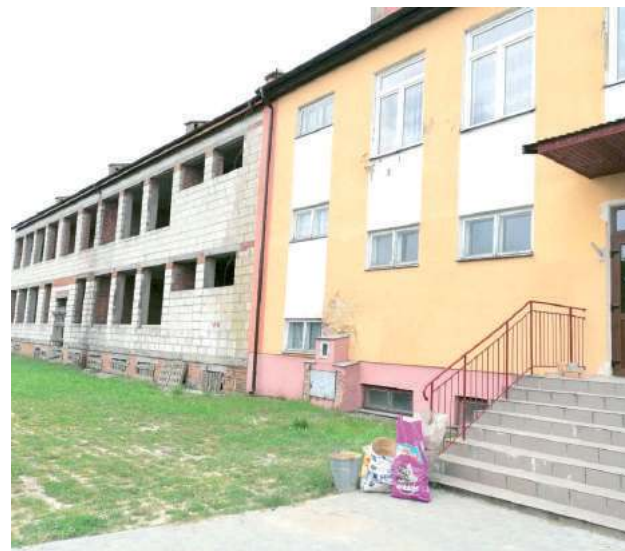
W Żabnie na zagospodarowanie czeka budynek w stanie surowym i bez okien
