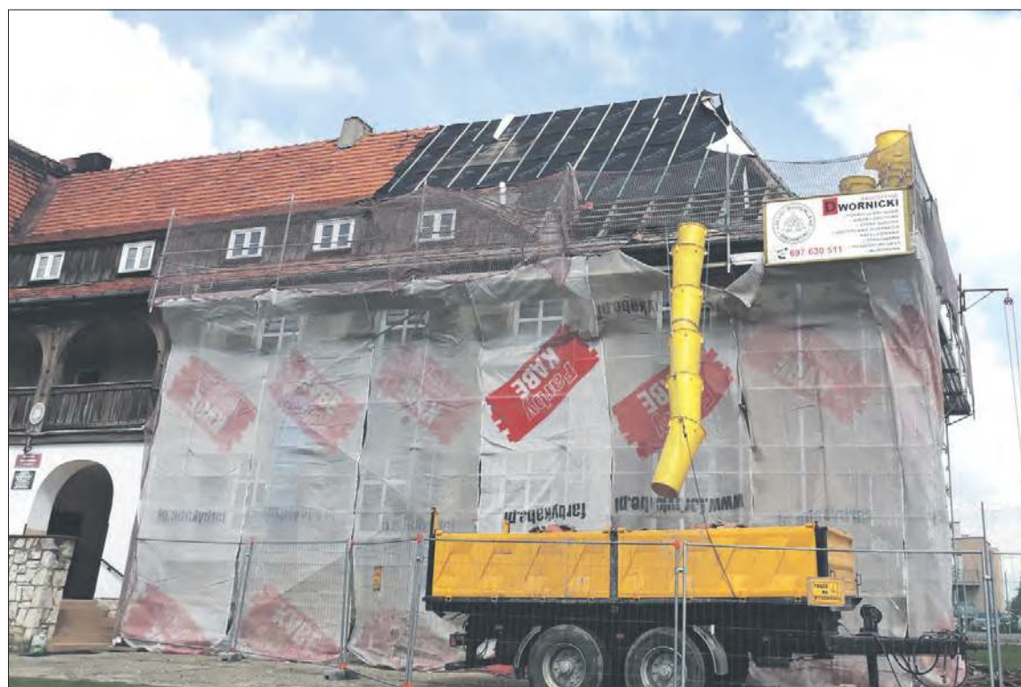
Remont dachu budynku szkolnego w Dytmarnowie
