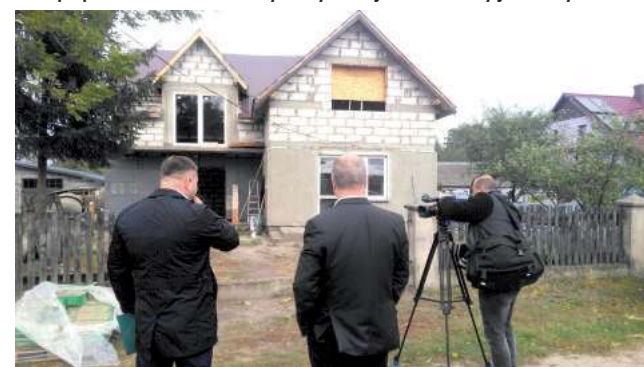
Pieniądze od stadnin pozwolą kontynuować prace wykończeniowe wewnątrz domu
