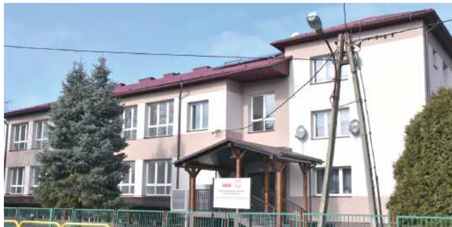
Pierwsze zadanie realizowane było pod nazwą „Termomodernizacja budynku szkoły w miejscowości Sól”
