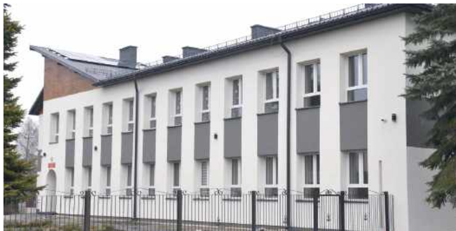
Drugie zadanie w ramach Rządowego Funduszu Polski Ład realizowane było pod nazwą „Przebudowa i zmiana sposobu użytkowania części budynku szkoły w miejscowości Ciosmy”
