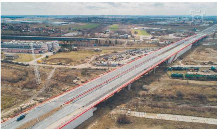
Przed tygodniem wiadukty pomyślnie przeszły próby obciążeniowe
