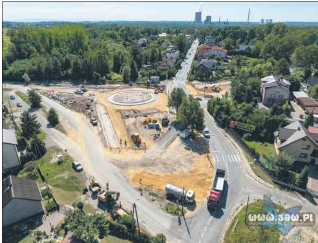
Ulica Nowoszczakowska – budowa nowej drogi w Jaworznie
