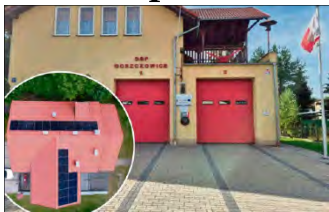
Zakończono modernizację energetyczną budynku Ochotniczej Straży Pożarnej w Goszczowicach.
