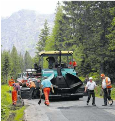
Remont drogi do Morskiego Oka
