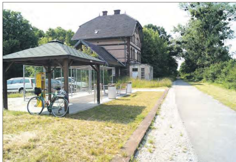
Przy ścieżce zbudowano infrastrukturę turystyczną
