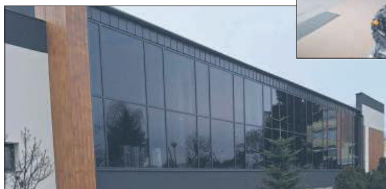
Termin zakończenia inwestycji planowany jest na 31 maja 2025 r.
