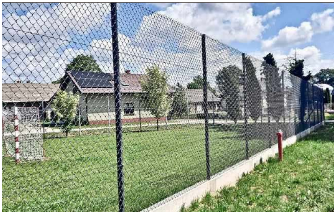
Ogrodzenie przy szkole w Mokrem już zostało zrobione.
