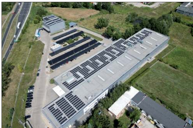
Fot. 1. Zastosowanie instalacji PV w budynki przemysłowym - dachy i car-porty Źródło: Solar-Volt
