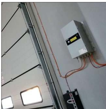
Fot. 3. Przemysłowy zasilacz awaryjny w hali magazynowej. Źródło: EVER
