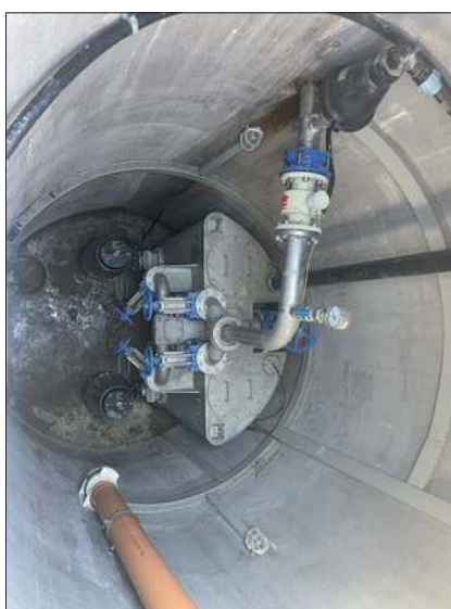
Fot. 1. W przypadku mniejszych układów kanalizacyjnych i usytuowania obiektu niedaleko terenów zabudowanych sprawdzi się cicha i hermetyczna tłocznia ścieków
