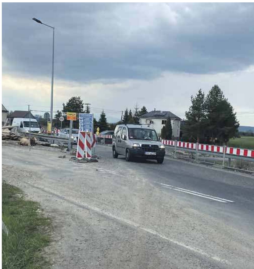
Remontowany most - tu ruch odbywa się wahadłowo.
