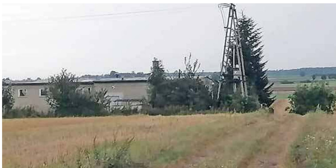
Ujęcie wody w Kałęczynie (gm. Gołymín Ośrodek)
