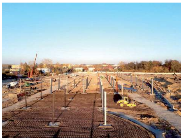
Wyjątkowo ciepła jesień sprzyja szybkiemu postępowi prac na budowie galerii
