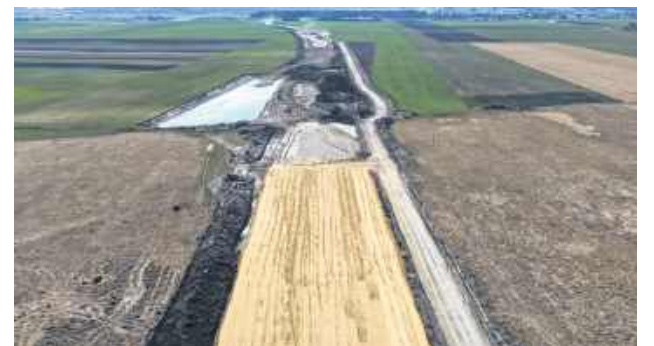
Budowę drogi ekspresowej S17. Fot. GDDKiA
