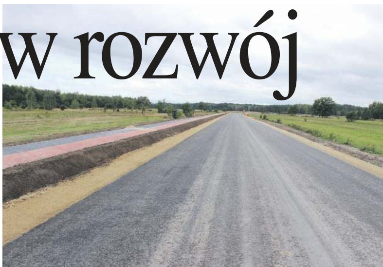
Wybudowanie drogi dojazdowej do terenów inwestycyjnych w Nowosieltcu pozwoli przedsiębiorcom na dostęp w pełnym zakresie do 56-hektarowego terenu przemysłowego
