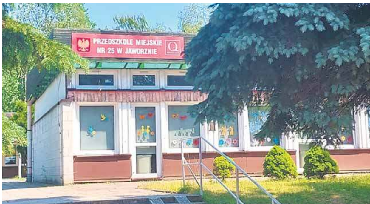
Budynek przedszkola ma zostać wyburzony
