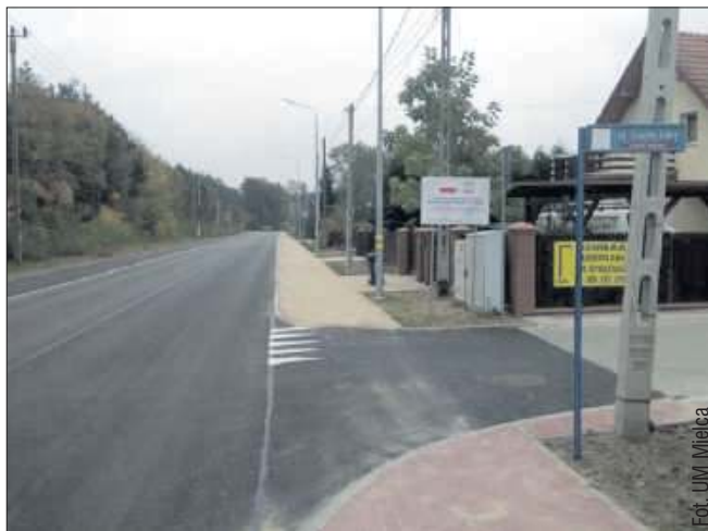
W ubiegłym tygodniu zakończyła się realizacja jednej z najważniejszych inwestycji drogowych zaplanowanych na terenie Mielca w roku 2020, jaką była rozbudowa ul. Królowej Jadwigi wraz z budową ul. św. Anny.
