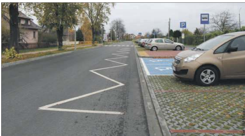
Wyremontowana ulica Przemysłowa w Mielcu.
