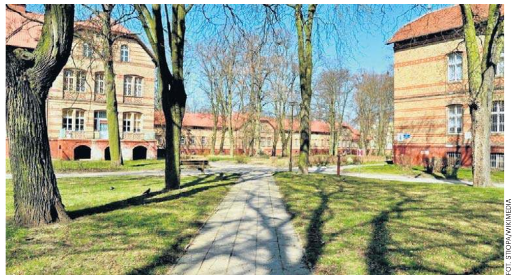
Pierwsze szpitalne budynki przy ul. Walczaka powstały w 1885 roku
