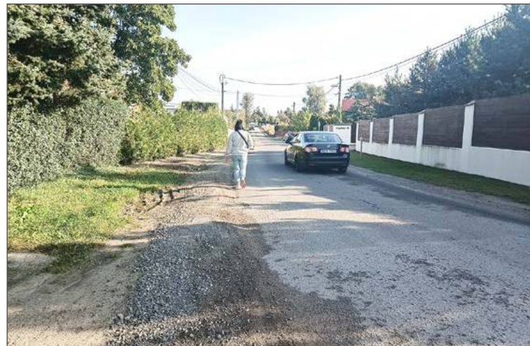
Ul. Polna po przebudowie ma być bezpieczniejsza.
