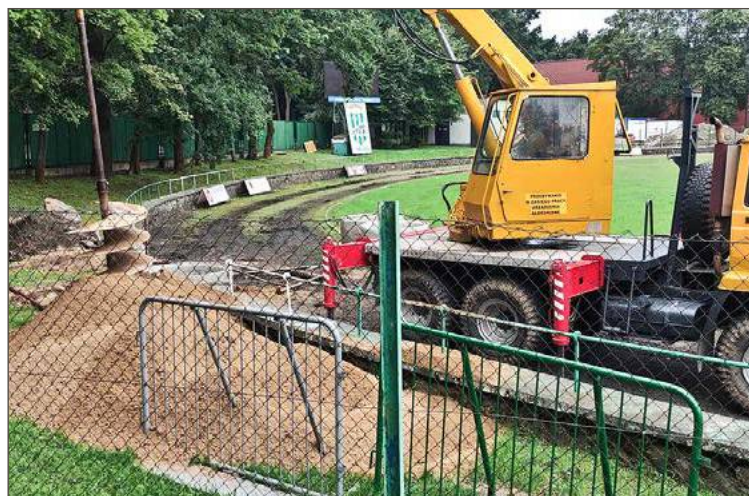
Od 2022 roku trwają prace na stadionie Wisłoki w Dębicy.
