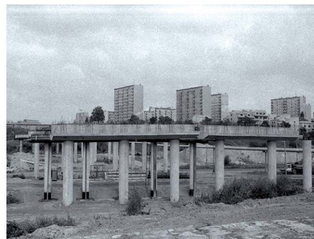
Budowa wiaduktu nad ulicą Filaretów
