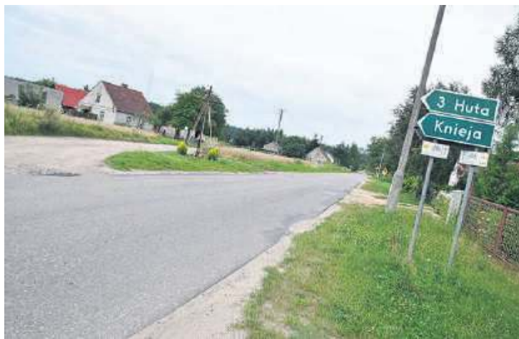
Ścieżka miałaby zaczynać się w tym miejscu, po prawej stronie drogi powiatowej. Zdjęcie wykonane jeszcze przed rozpoczęciem remontu odcinka w kierunku Huty.
