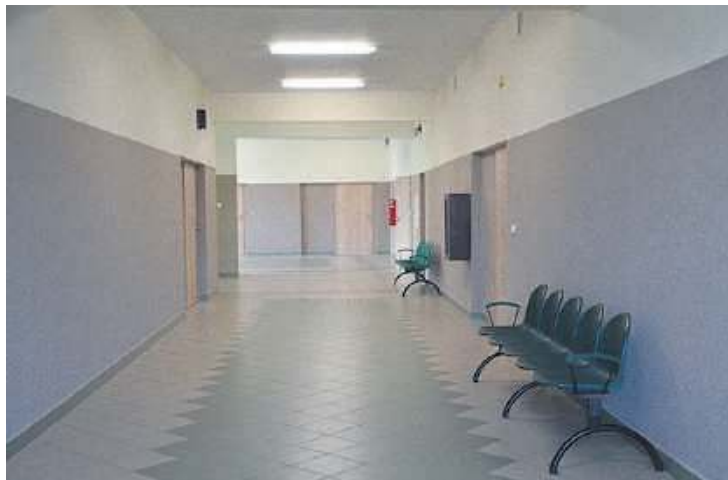
Wyremontowany korytarz. Po nawałnicy ta część szkoły była zalana.
