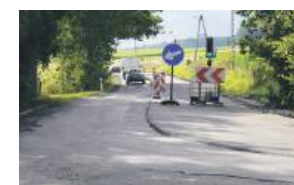
Trwają prace remontowe w Jagielnicy
