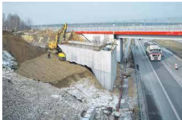
Budowa wiaduktu nad A1. Pod powstającą konstrukcją prowadzony jest ruch samochodowy
