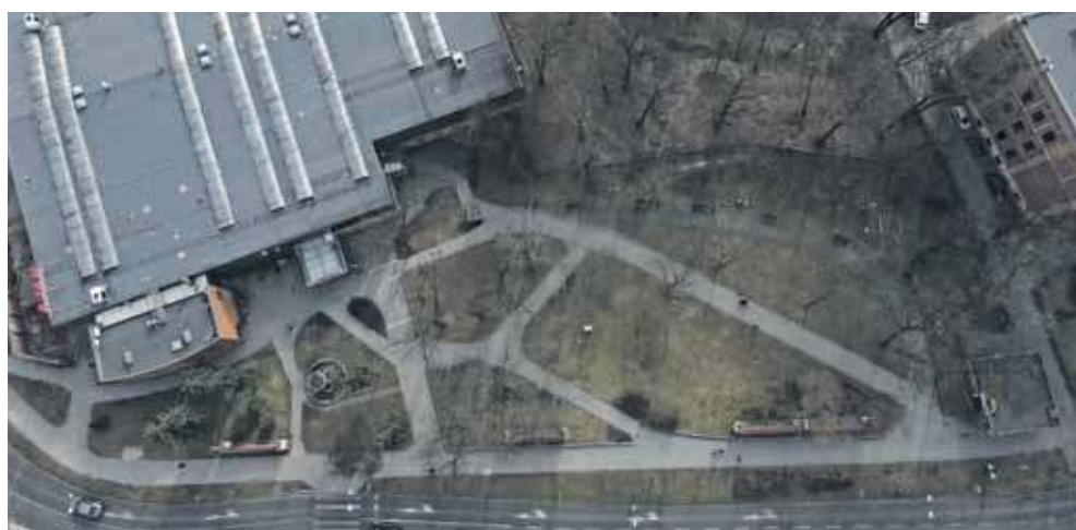
Ma być więcej zieleni. Zburzony zostanie pawilon dawnej kwiaciarni, betonowe reklamy przy ulicy i murek przy liceum
