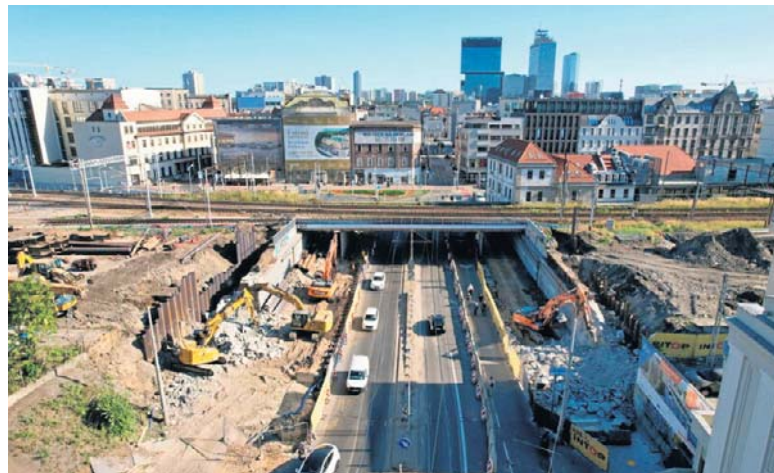
Tak wygląda dziś przebudowa wiaduktu nad ul. św. Jana
