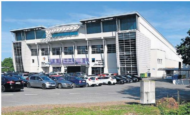
Na dachu hali i na specjalnych zadaszeniach parkingowych, tak zwanych carportach, zostaną zamontowane panele fotowoltaiczne
