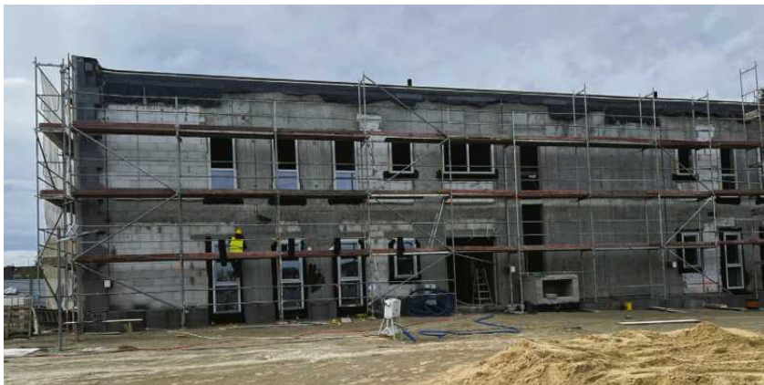
Budowa przedszkola w Wilczopolu
