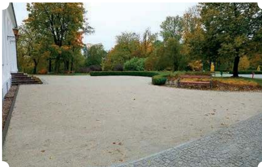
Aleje po wykonanym remoncie
