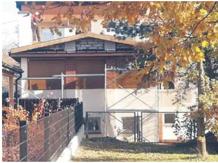
Taras w trakcie budowy
