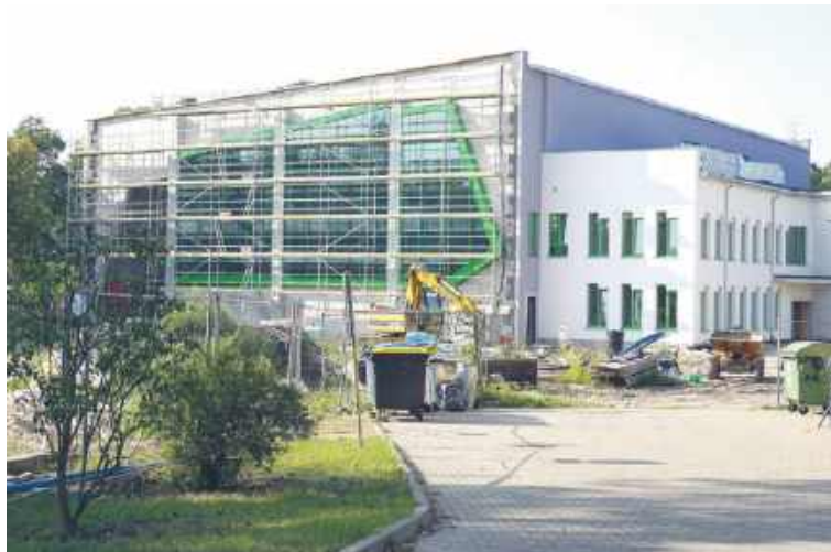
Budowa zmierza do finału, a niektóre firmy nie dostały zapłaty. fot. sej
