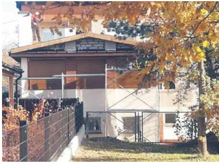
Taras w trakcie budowy
