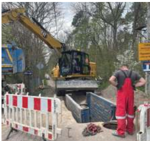
Przebudowa wodociągu w ul. Polnej
