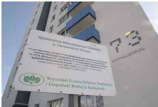
Wcześniej SM Gwarek otrzymała wsparcie WFOŚiGW w Katowicach m.in. na unieszkodliwienie płyt azbestowo-cementowych, którymi przed laty ocieplono wieżowce na Osadzie Jana
