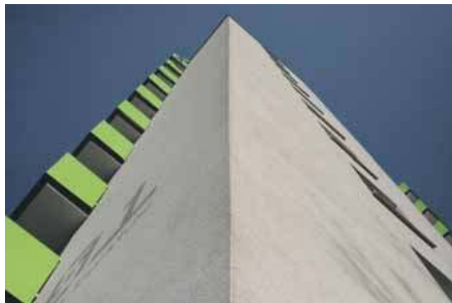
W ramach projektu m.in. ocieplono elewację płytami styropianowymi oraz wymieniono balustrady balkonowe
