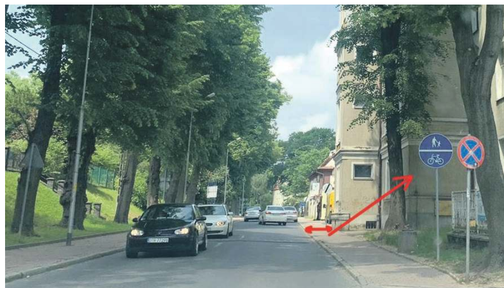
Do niedawna tak wyglądała ścieżka pieszo - rowerowa przy ul. 1-go Maja w Trzebnicy. W wielu miejscach szerokość była niezgodna z przepisami, ale urzędnicy i tak prace odebrali, a wykonawca otrzymał kasę. Dzisiaj tego odcinka już nie ma, a znaki "zniknęły"
