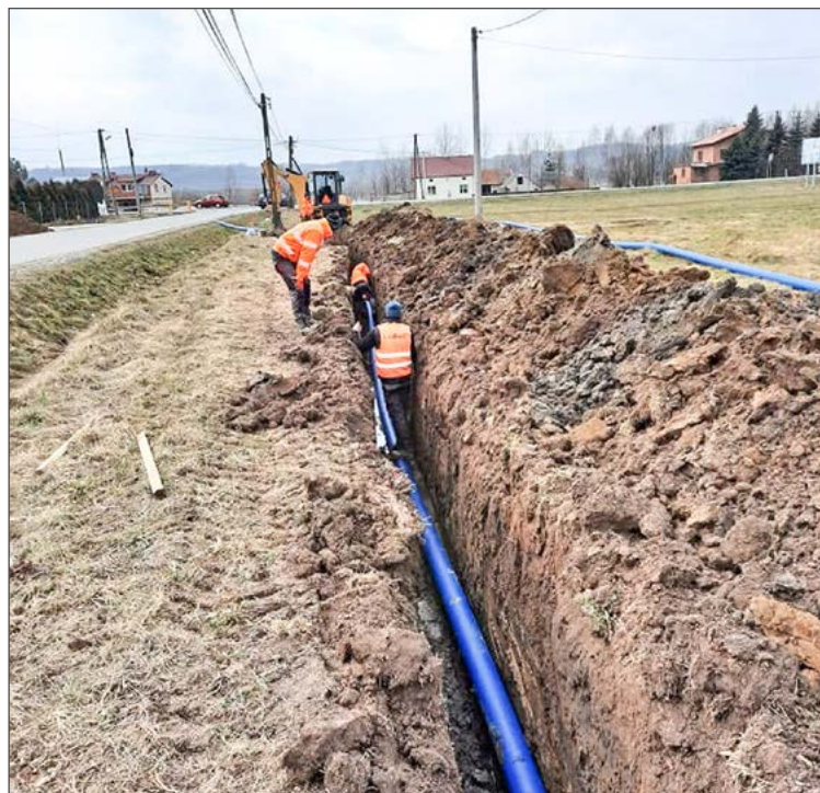
To kolejna szansa na to, by mieszkańcy w końcu mieli dostęp do wodociągu i kanalizacji. Fot. Arch.
