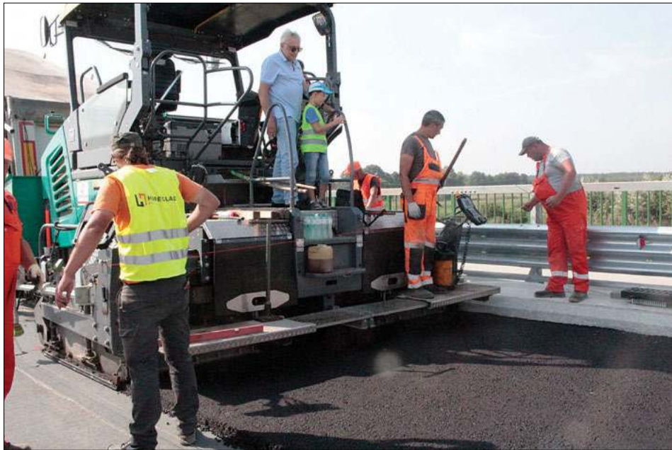
Doskonałym potwierdzeniem obietnicy danej Krzysowi przez św. Mikołaja jest to, że Krzyś jest dziś na budowie - mówi Leszek Horeglad, prezes PRD S.A., który zaprosił ośmiolatka, by pokazać mu, jak pracuje jego firma
