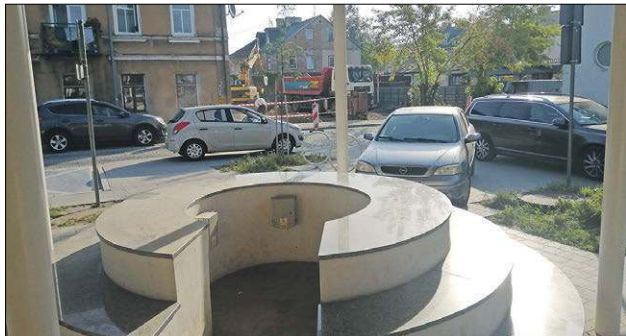
Prace wyburzeniowe już się zakończyły, a firma Żwir-Bud, która wykonuje zlecenie za 150 tys. zł, w ramach umowy ma teraz dokonać utwardzenia całej działki (na zdj. w tle)
