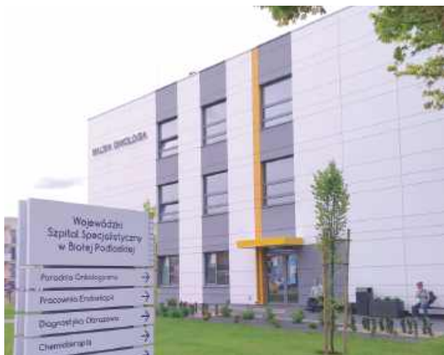
Obok pierwszego budynku Bialskiej Onkologii ma powstać dwukondygnacyjny obiekt Poradni Radioterapeutycznej
