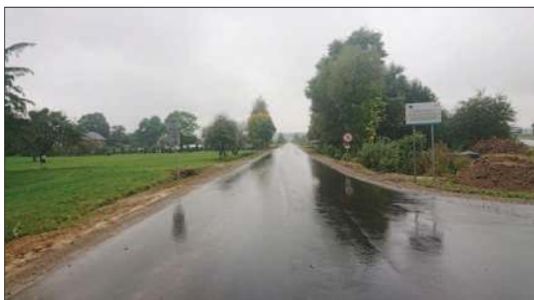
▲ Przebudowa drogi gminnej
