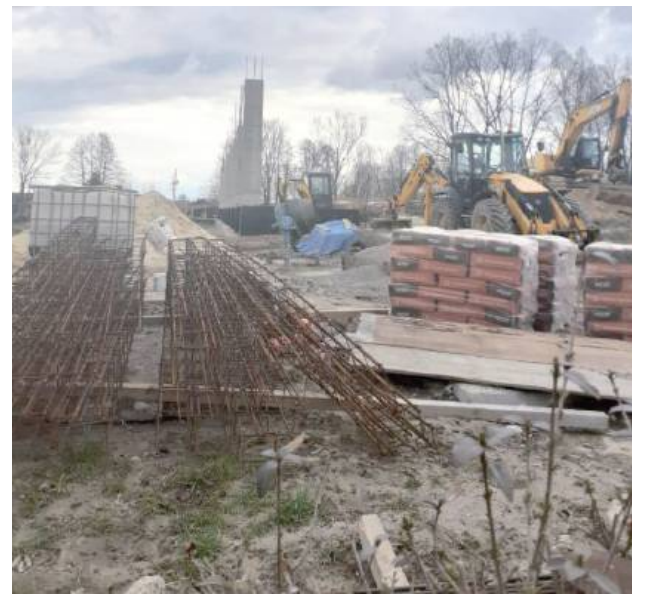
Budowa hali w Potoku Górnym ma zakończyć się w październiku przyszłego roku
