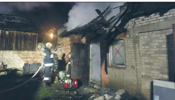
W nocy z 20 na 21 listopada 2023 roku straż pożarna została zaalarmowana o pożarze w miejscowości Ułęż. Na miejscu z pożarem walczyło pięć zastępów strażaków. Pożar wybuchł w budynku gospodarczym, który został przekształcony w mieszkanie. Samotnie mieszkał w nim 54-letni mężczyzna. Wydobytym z dymu zauważyli sąsiedzi. Po ugaszeniu ognia mieszkanie przewietrzono. Strażacy weszli do środka. Były przypuszczenia, że wewnątrz może ktoś się znajdować. Niestety czarny scenariusz potwierdził się. Ratownicy natrafili na ciało mężczyzny. Było tak mocno zwęglone, że trudno było stwierdzić, czyje to zwłoki. Decyzją prokuratora zostały skierowane na sekcję, która potwierdziła, że w pożarze domu zginął 54-letni właściciel (fot. OSP KSRG Ułęż)
