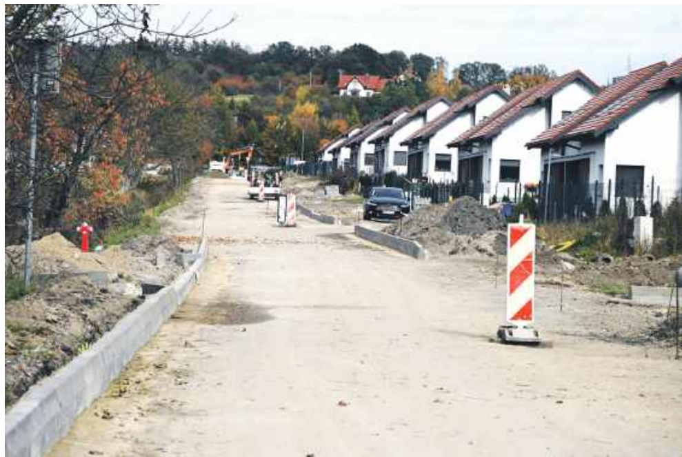
Na ul. Szkolnej w Wiszni Małej trwają prace związane z układaniem krawężników
