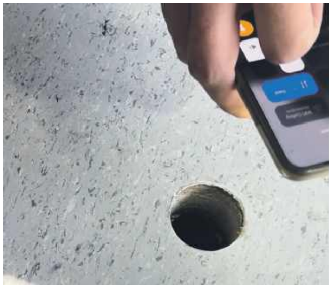
W żłobku w podłodze trzeba było wierceć dziury, żeby osuszyć posadzkę, pod którą zebrała się woda
