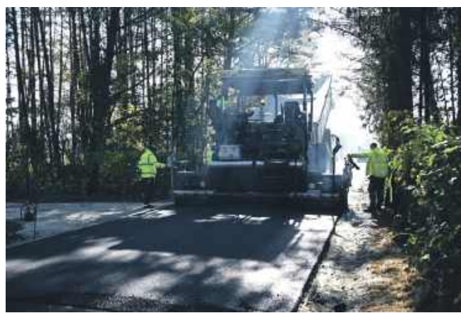
Układanie nawierzchni bitumicznej na ul. Łąkowej w Ozorowicach
