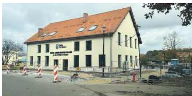
To zdjęcie wykonaliśmy w środę, 30 października. Jak widać budowa dalej trwa
