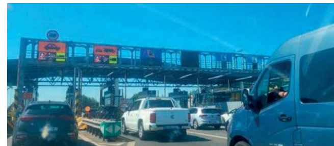
Bramki na autostradzie A4
