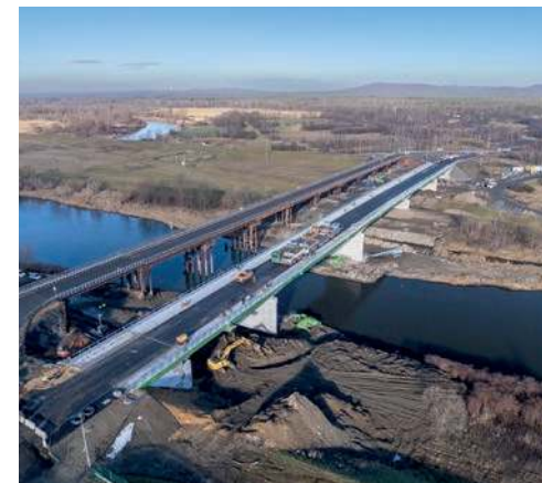
Nowy most na Wiśle w Jankowicach. Fot. Nowak-Mosty
