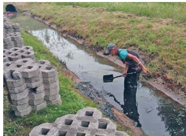
Prace przy udrażnianiu rowów są niezwykle ważne (fot. UM Nowa Sól)
