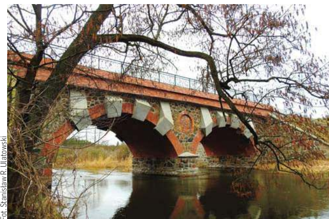
Zabytkowy most kolejowy nad Drwęcą w Białej Górze
