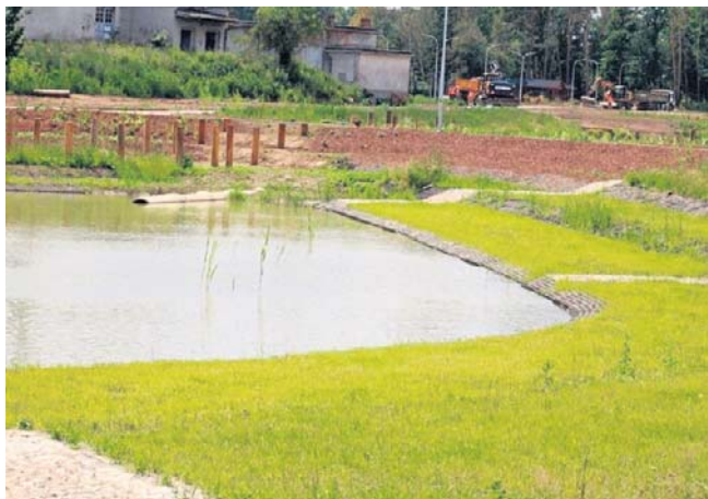
Na budowie nowego parku na radomskim Wacynie jest coraz bliżej finiszu. Będzie tu osiem stawów.
