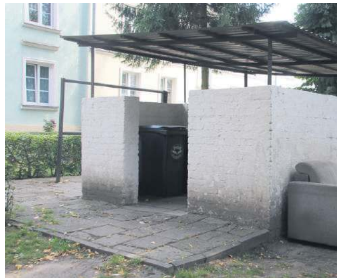
Fotel obok śmietników przy ul. Kościuszki. Raczej nie służy teraz celom
