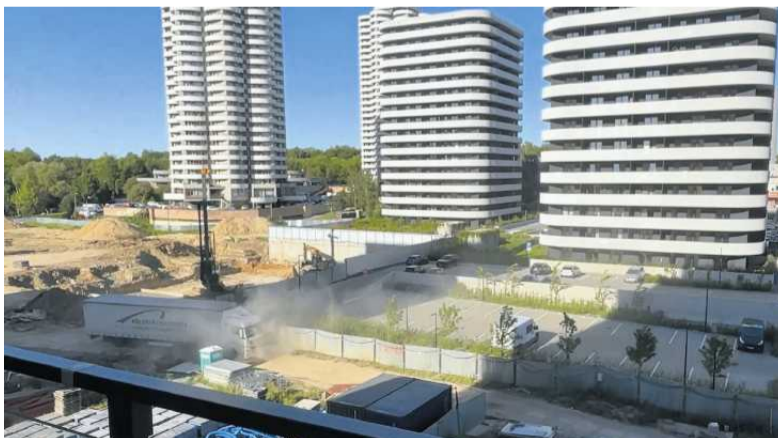
• Budowa na Osiedlu Tysiąclecia w Katowicach FOT. ARCHIWUM PRYWATNE
