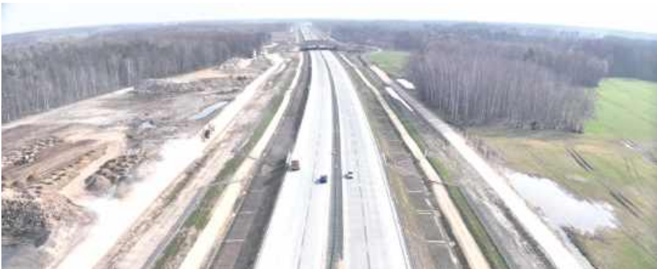
Autostrada A2 na odcinku Biała Podlaska Siedlce ma dwie jezdnie z dwoma pasami ruchu oraz rezerwą pod dobudowę trzeciego pasa. Dla pieszych i rowerzystów przewidziano nowe chodniki i ścieżki rowerowe. Powstaną tam dwie pary miejsc obsługi podróżnych (MOP), najpierw tylko z parkingiem, jezdniami manewrowymi, toaletami, oświetleniem oraz ławkami. Dopiero później mogą powstać stacje paliw i restauracje. Szacunki mówią, że po oddaniu autostrady A2 na tej trasie ma poruszać się 20 tysięcy pojazdów na dobę
