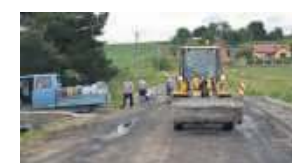
Obecnie trwa I i III etap przebudowy drogi powiatowej w Gościęcicach
