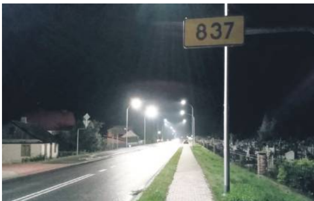
Nowe lampy przy przebudowanej drodze wojewódzkiej nr 837 mają przez 5 lat palić się przez całą noc.
