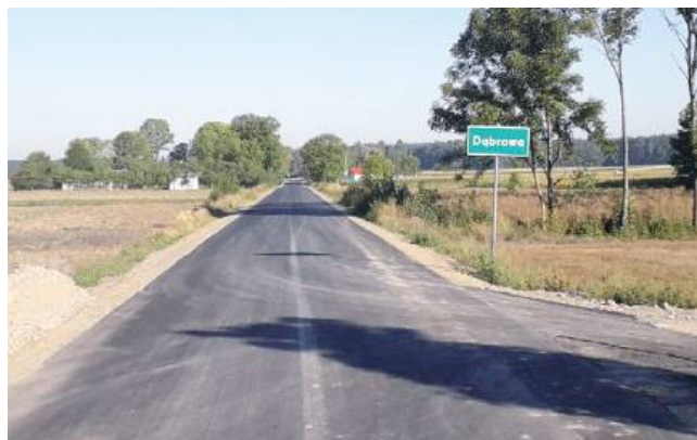
W Dąbrowie asfalt ułożono na odcinku ponad 1,7 km.
