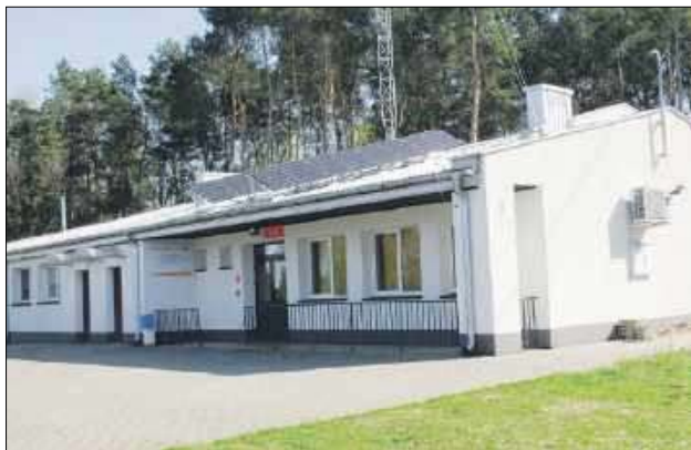
Dom Ludowy w Ostrówkach po przebudowie
